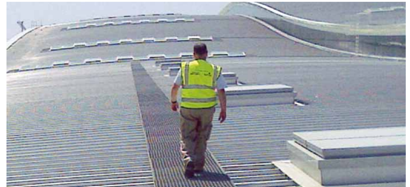
Operario realizando inspección de la cubierta de la Terminal
